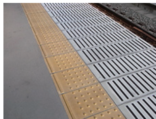
内方線付点状ブロック
