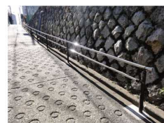
急な手すりへの 手すりの設置
