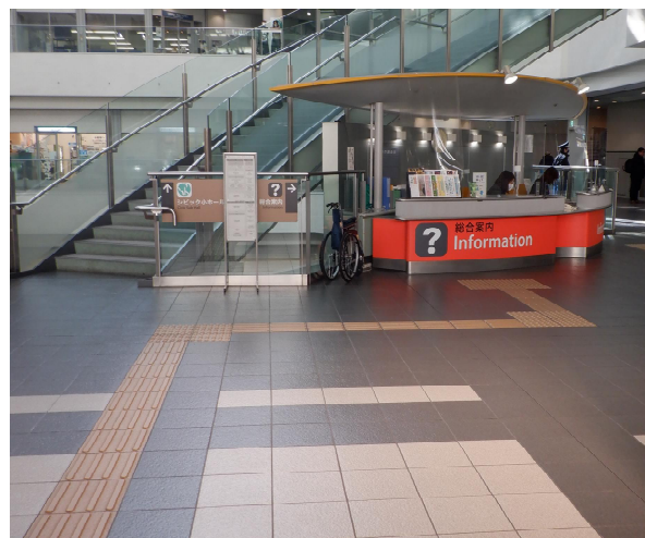
建築物出入口から案内施設への視覚 障害者誘導用ブロックの連続設置・ 総合案内(人による対応)
